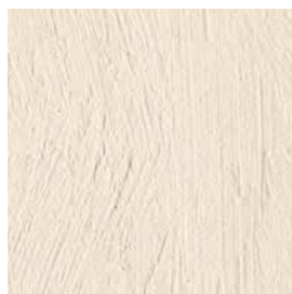
F385 ST10 s. 79 Tynk surowy
